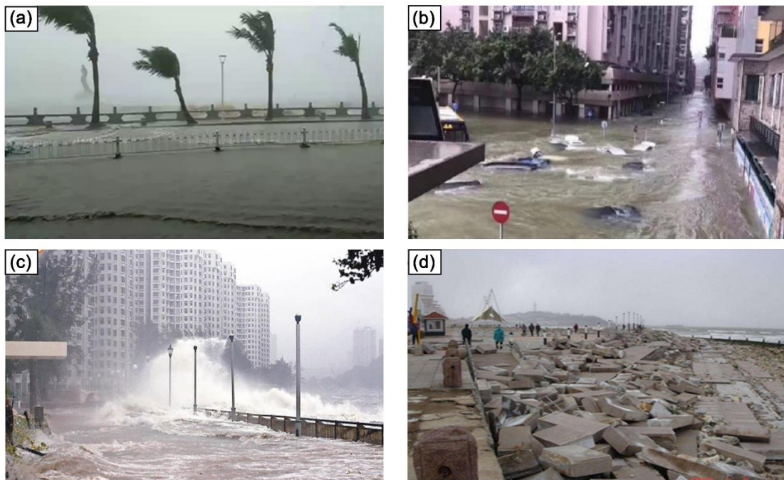
图 2 (a) 台风“天鸽”登陆时的漫堤水流；(b) 风暴潮漫堤造成的城市淹水； (c) 台风“山竹”登陆时的漫堤水流；(d) 风暴潮对海堤造成的破坏
